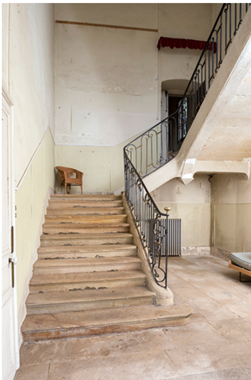
Vue de trois-quart de l'escalier principal.
