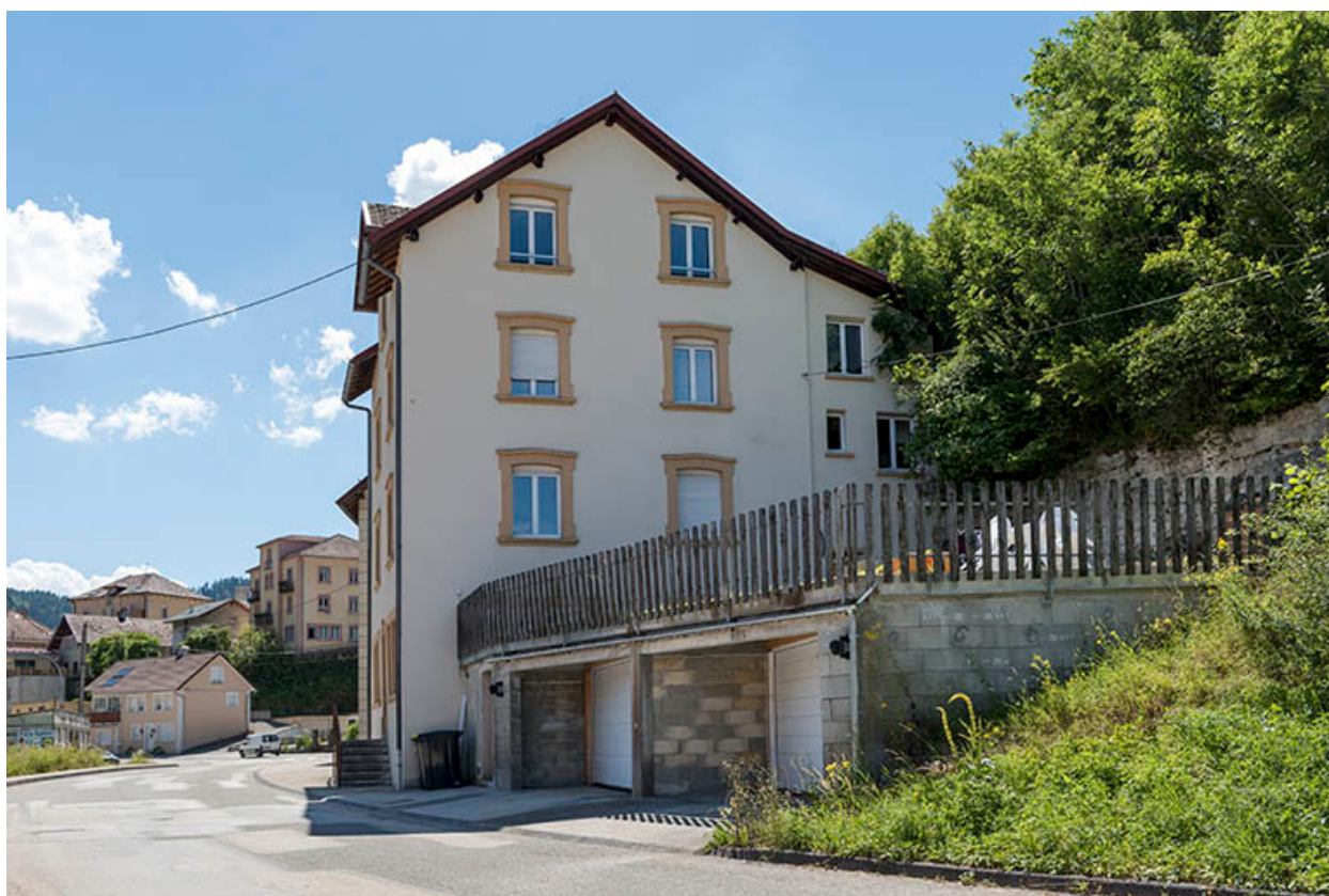
Façade latérale droite.
