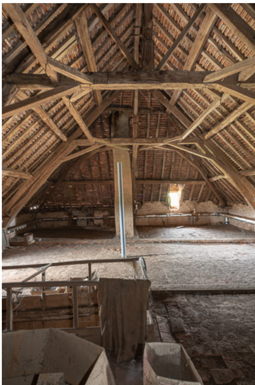
Vue de la charpente de la demeure
