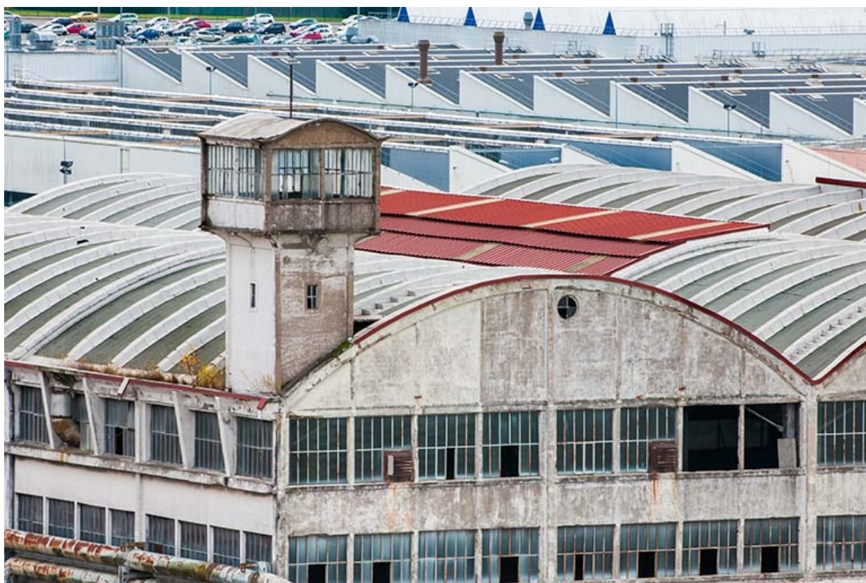
Toitures de l'usine Peugeot de Sochaux-Montbéliard.
