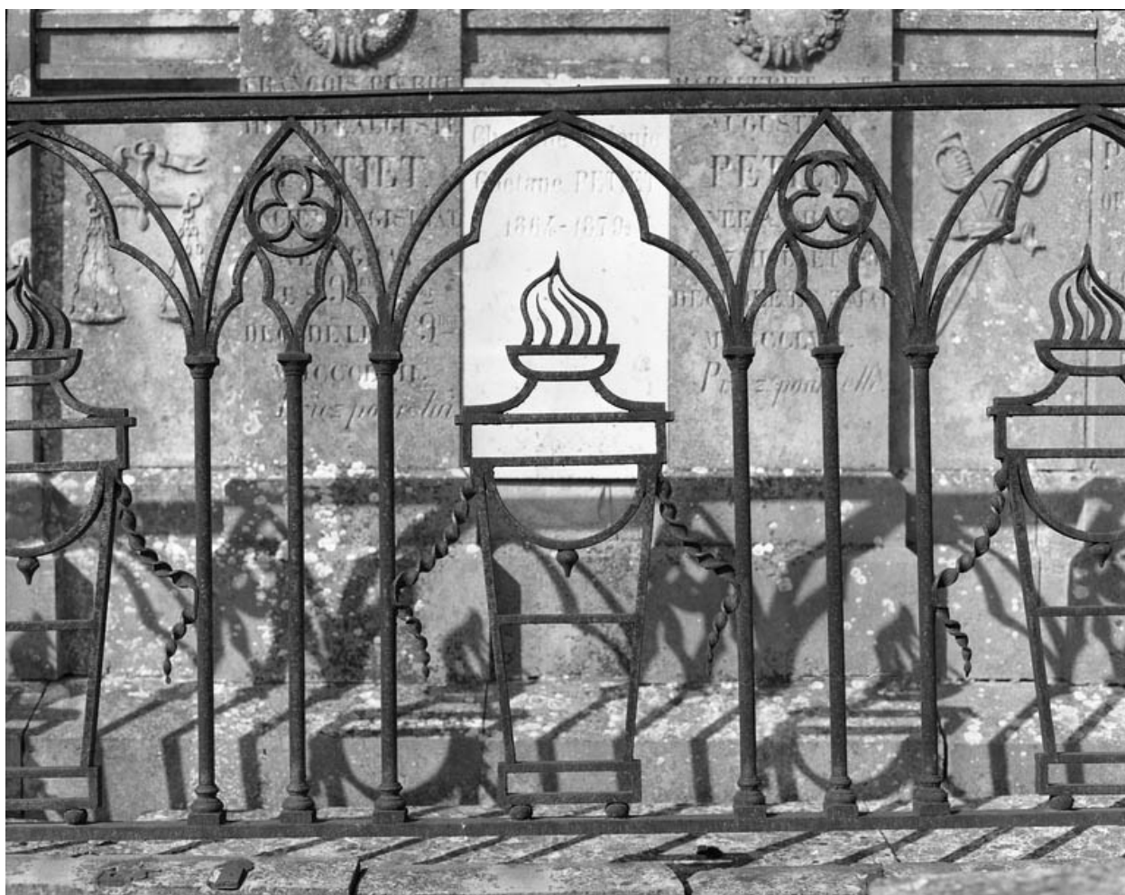
Détail de la clôture.
