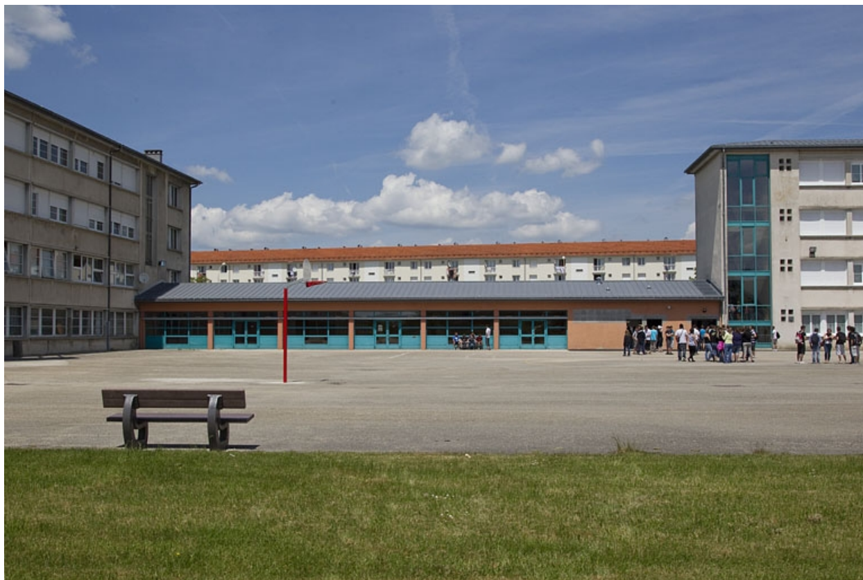
Bâtiment de l'administration : face postérieure.
