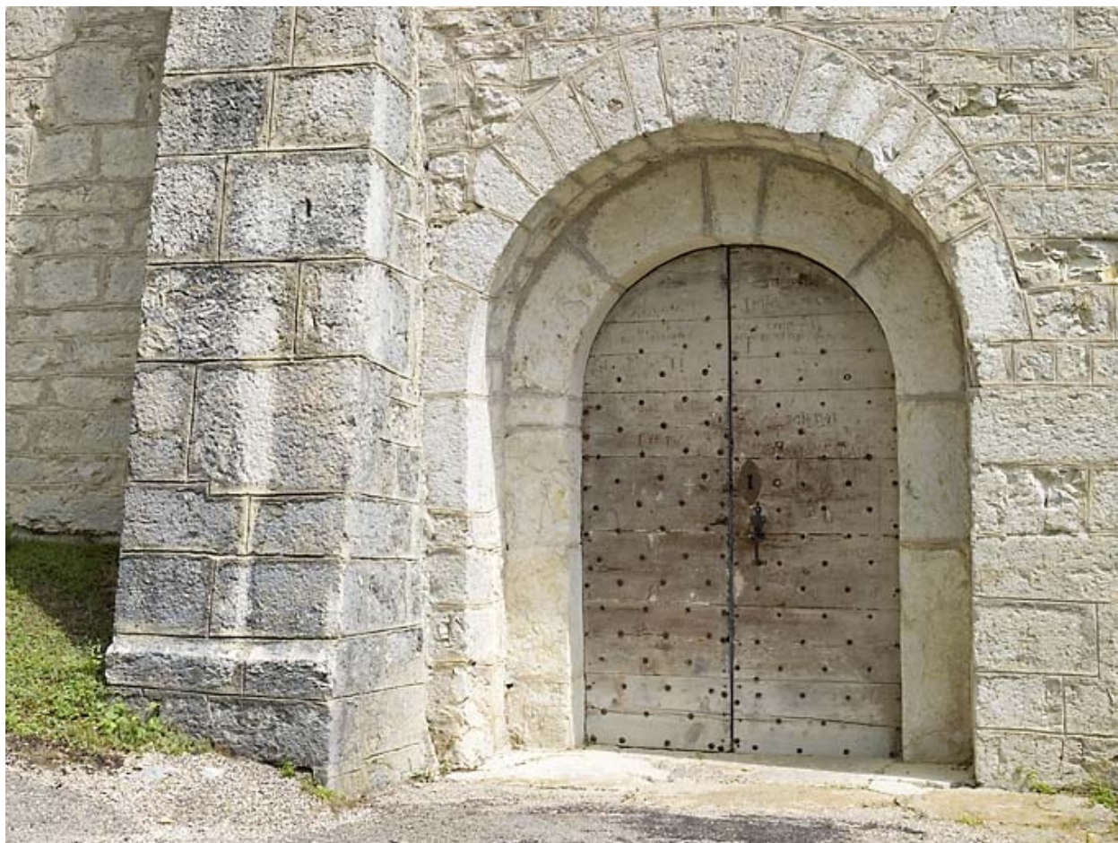
Façade sud : entrée.
