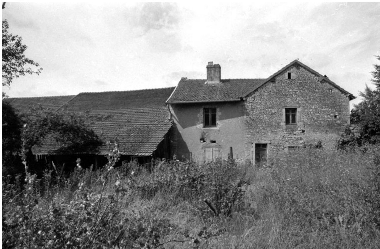
Façade postérieure de la partie gauche.
