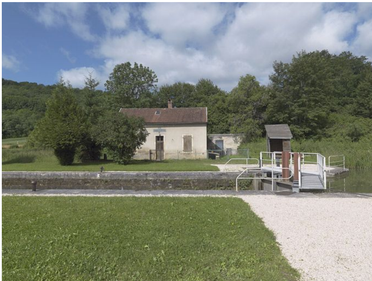
Maison éclésièr de face.
