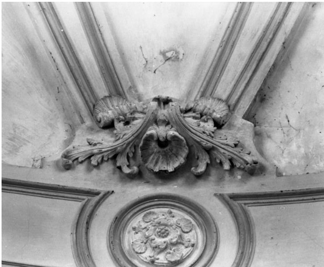
Choeur, détail de la voûte
