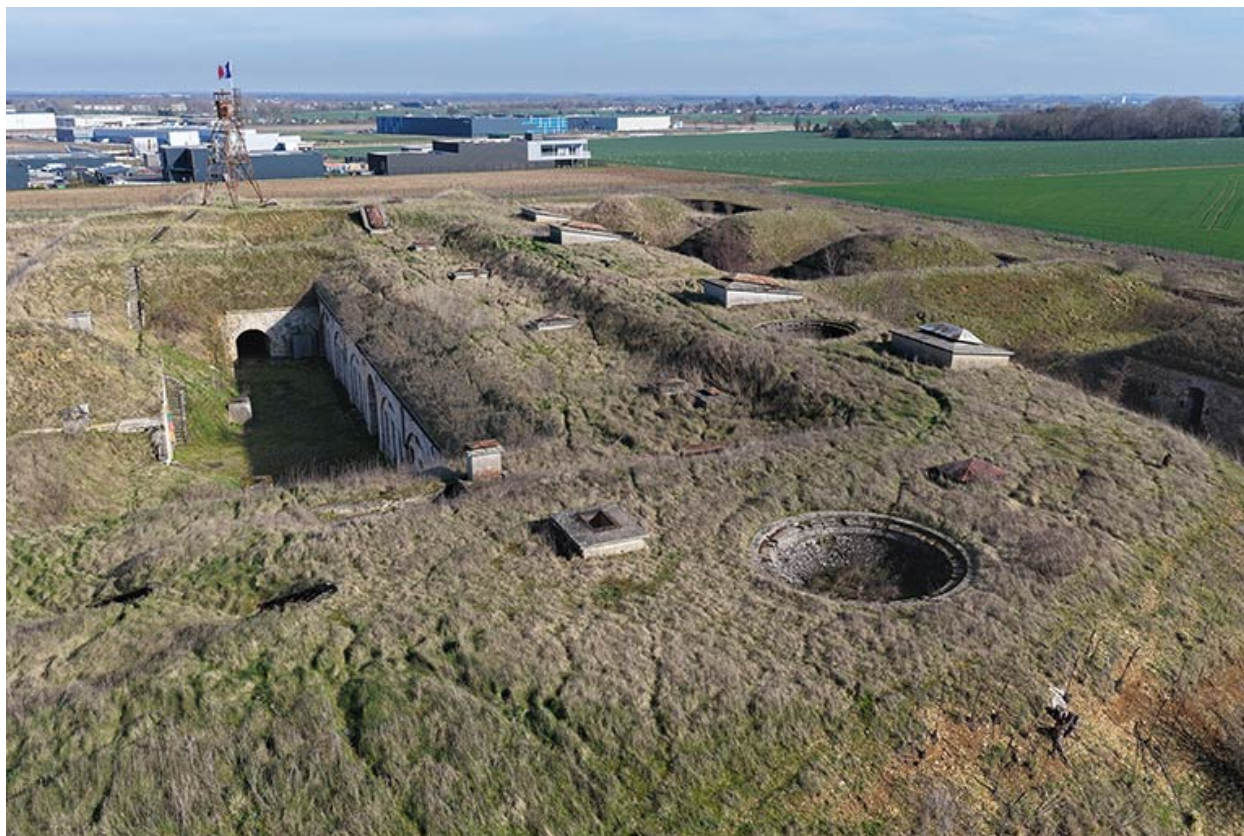
Cuve pour canon anti-aérien. (vue aérienne).
