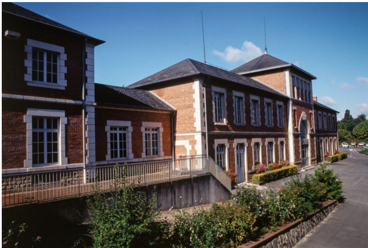
Bâtiment de service.
