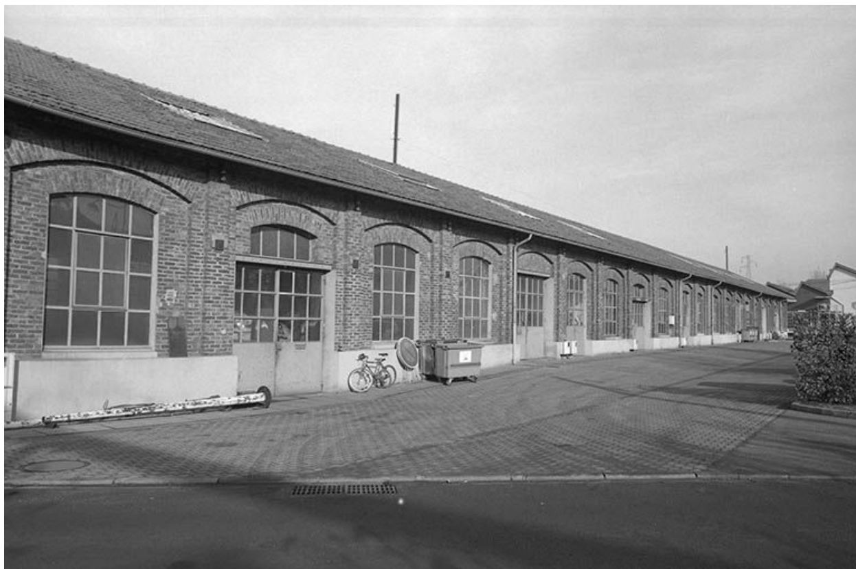
Charpenterie et charronnerie vues de l'est.
