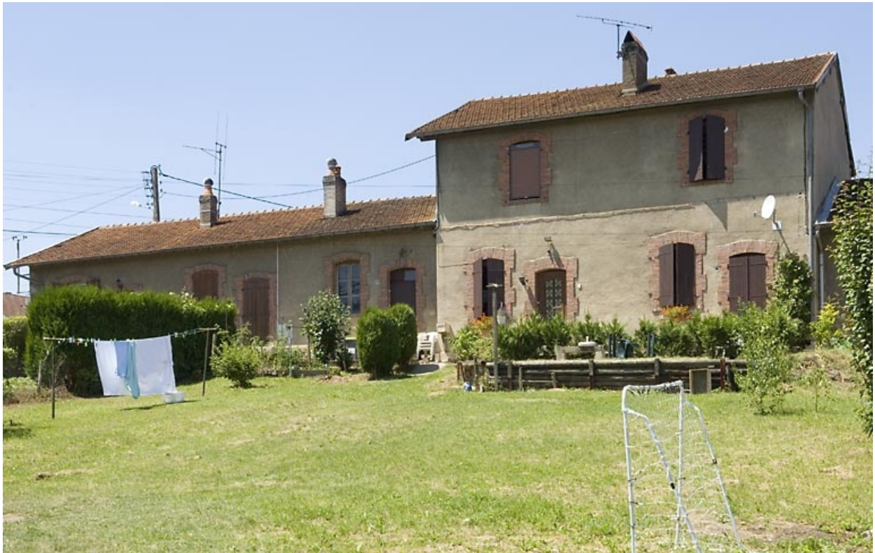
Logements ouvriers depuis l'ouest.
