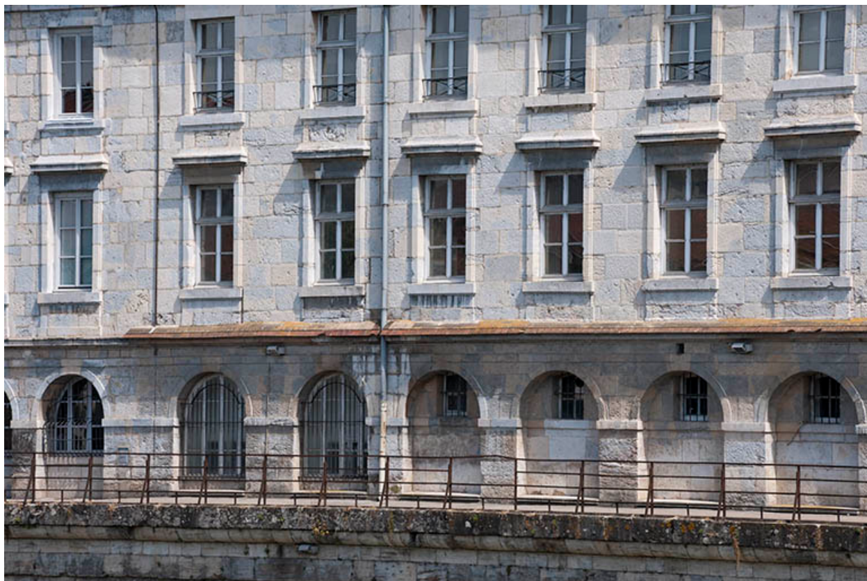
Façade postérieure : partie gauche, vue de trois quarts droite.
