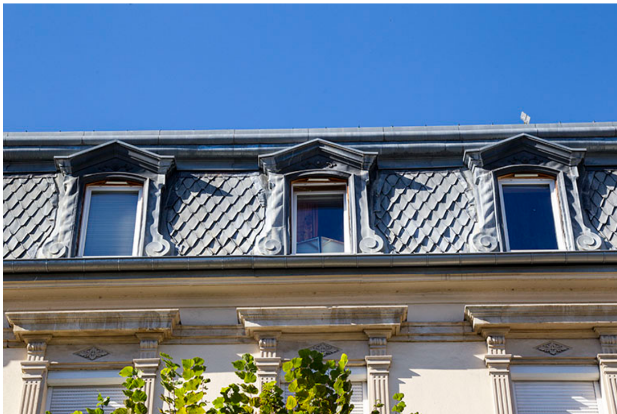
Façade antérieure : baies du brisis.
