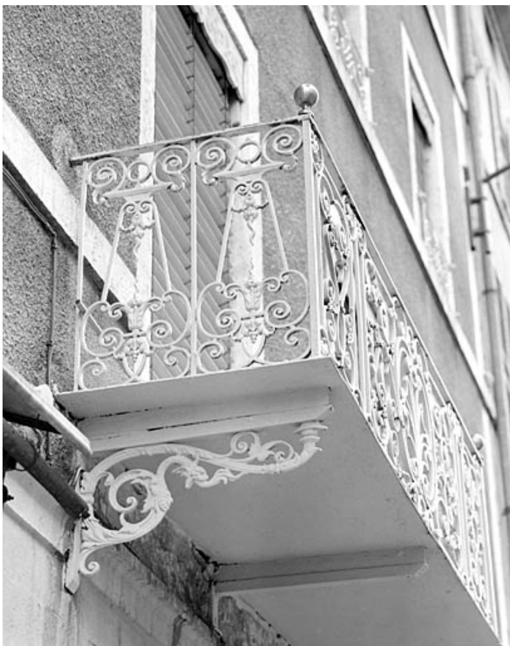
Balcon du premier étage : garde-corps et console.
