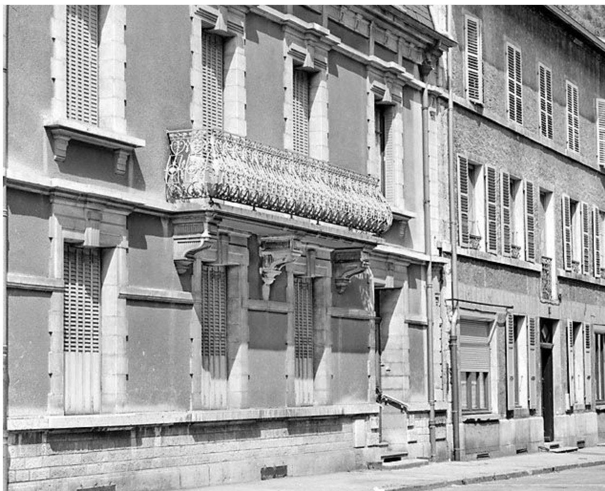
Elévation antérieure : baies.
