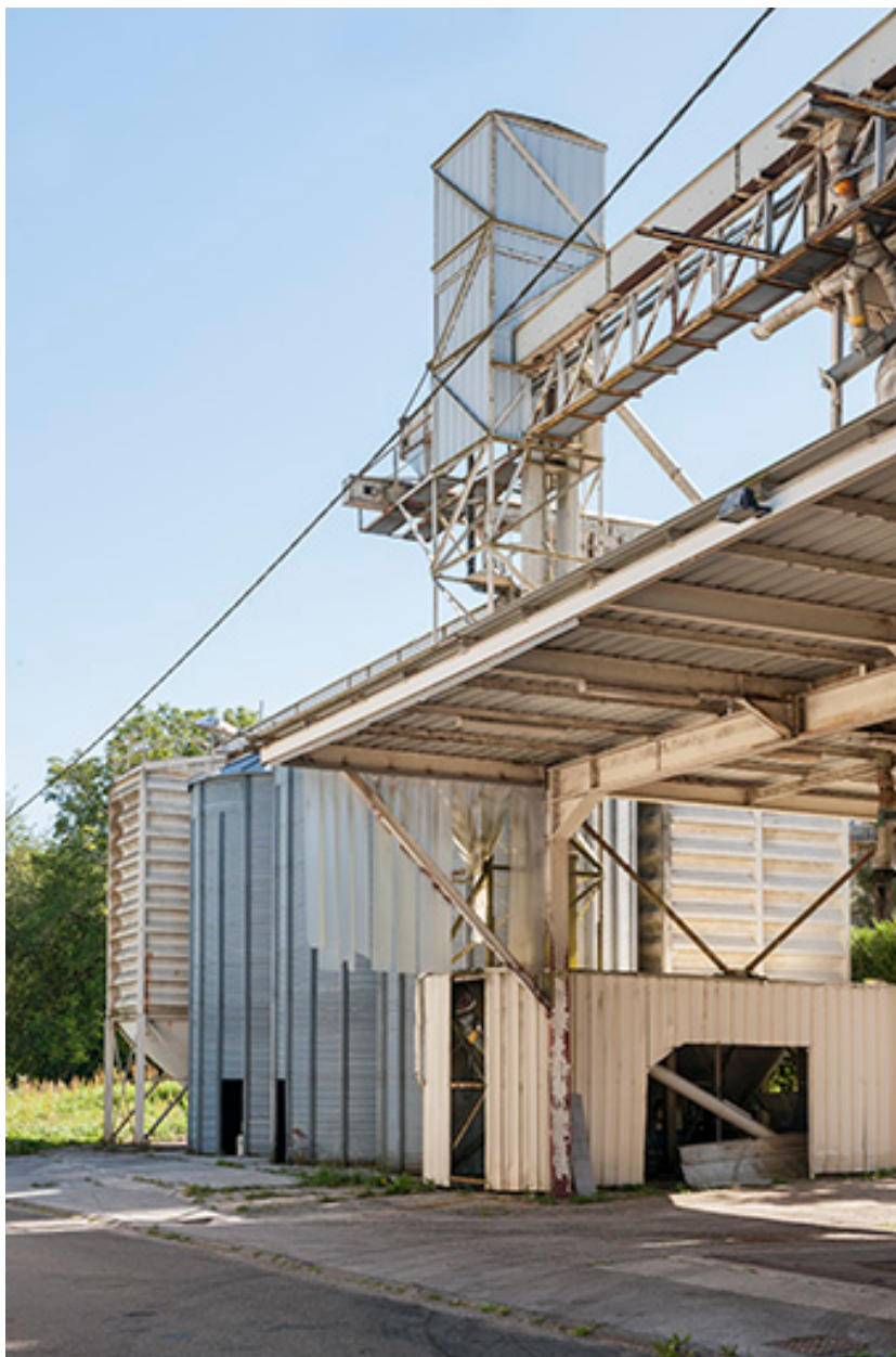
Installations de chargement/déchargement.
