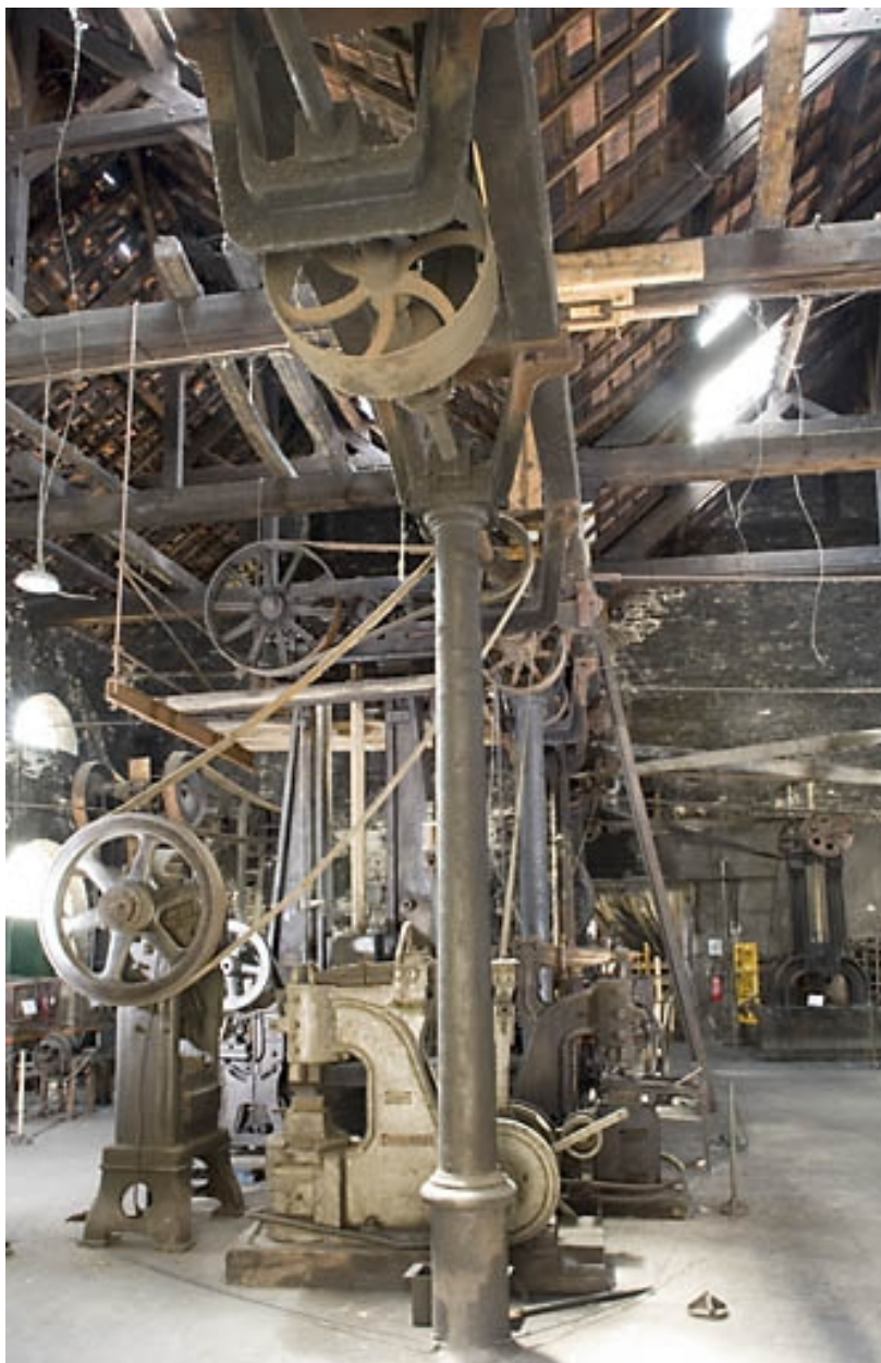
Intérieur de l'atelier est. Vue depuis l'est.
