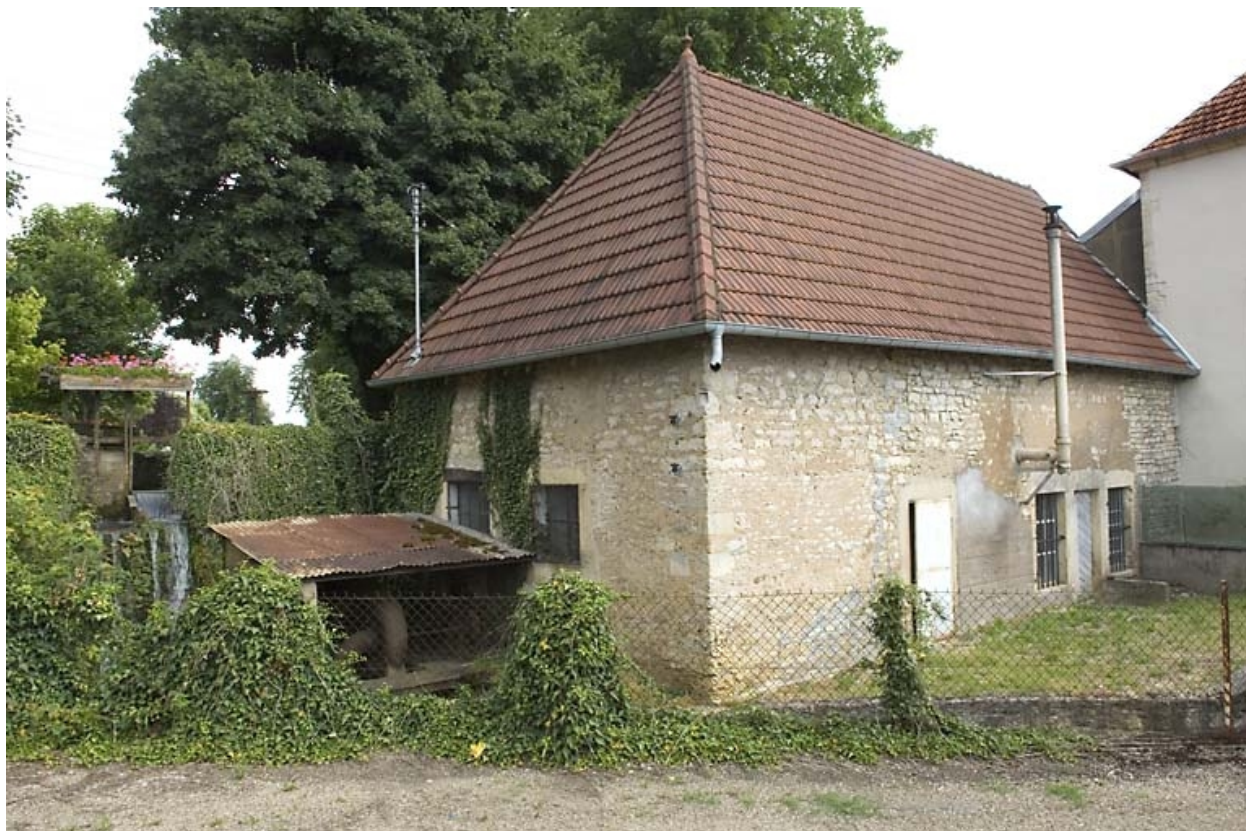
Local de la turbine et atelier.
