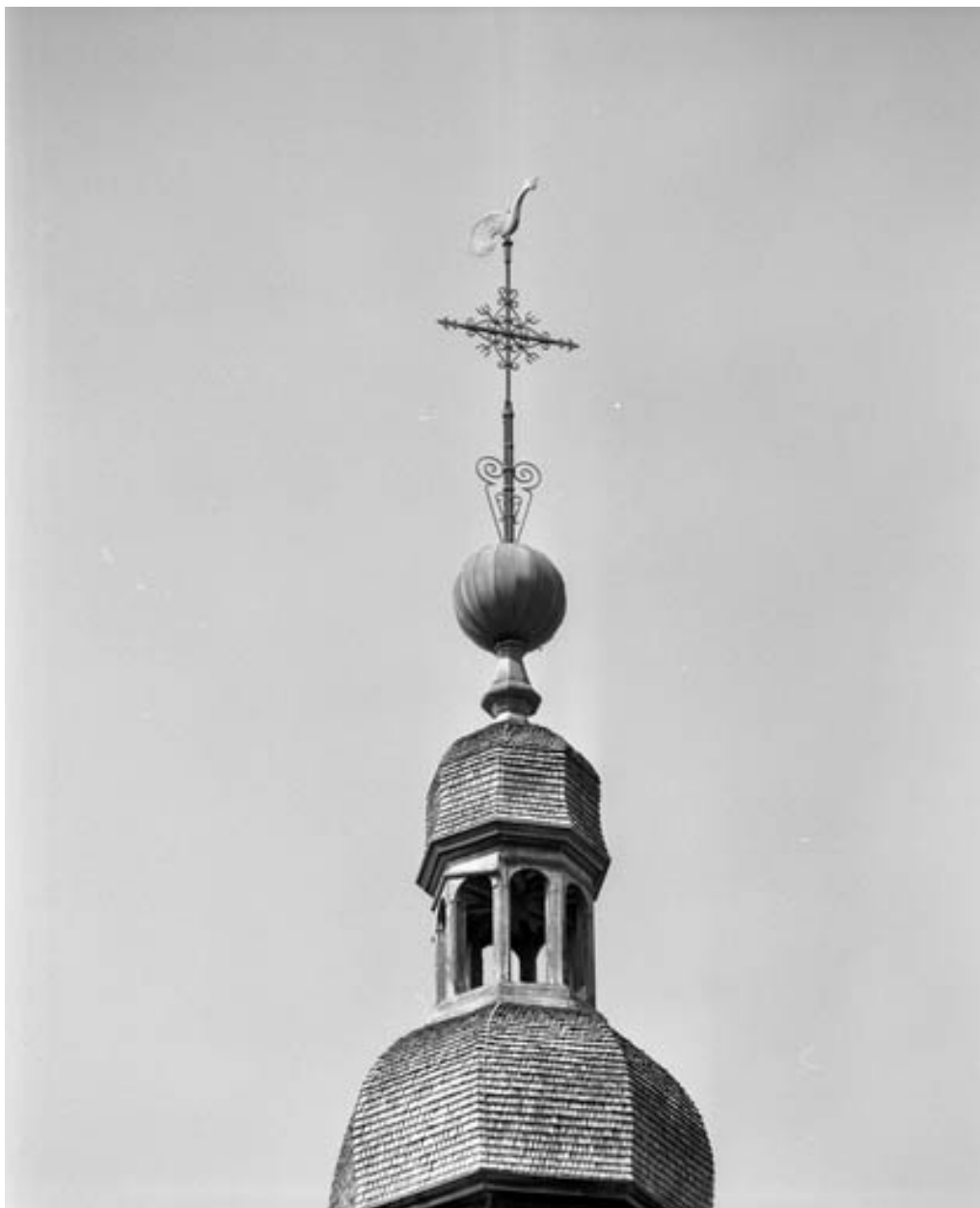
Tour-clocher : détail du lanternon.
