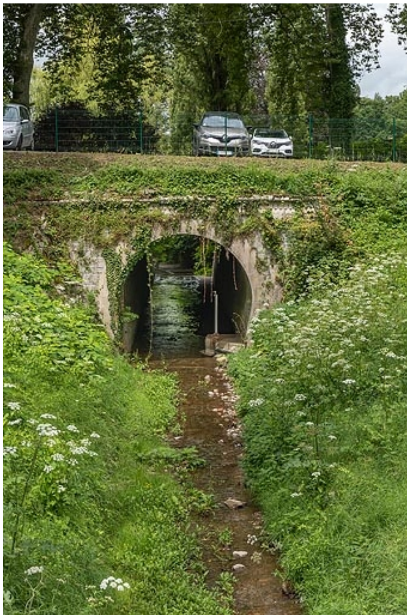
Tunnel du Borne sous l'allée d'Aligre.
