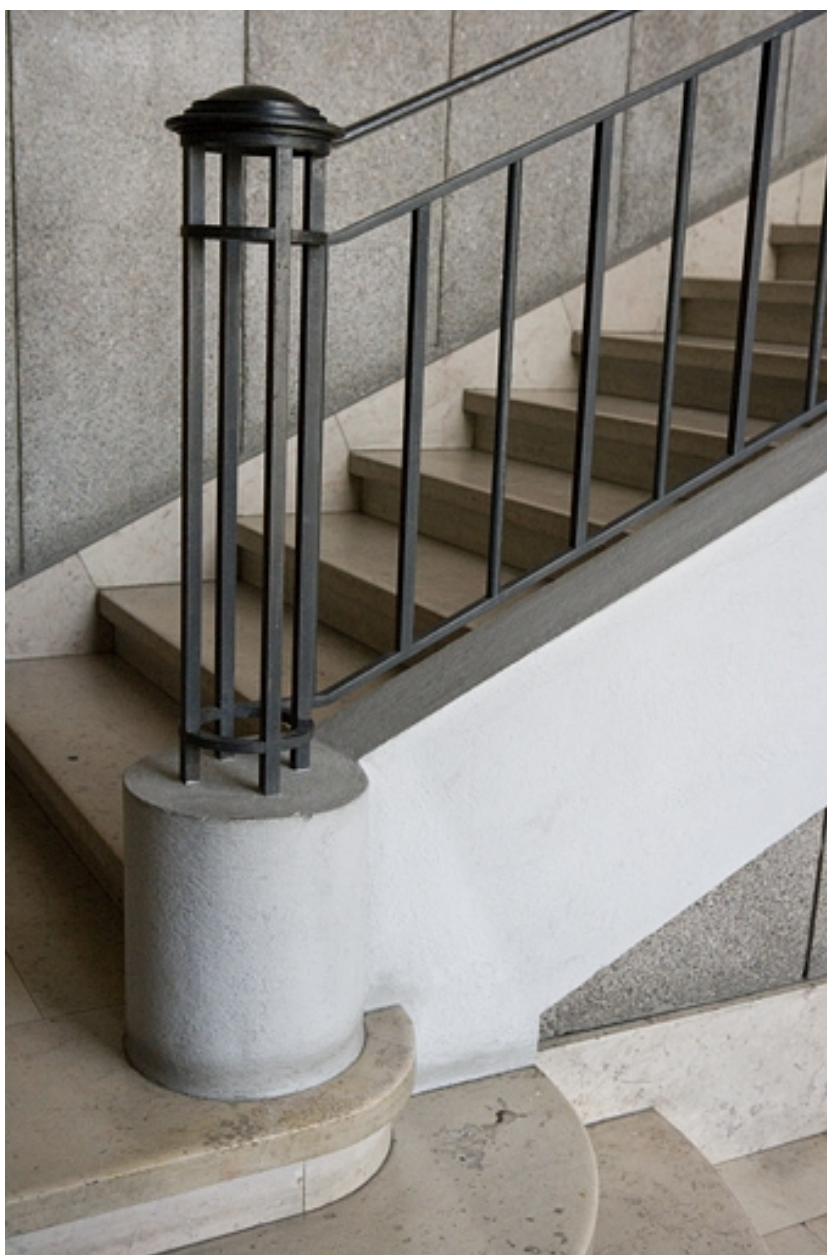
Cage d'escalier : départ de la rampe.
