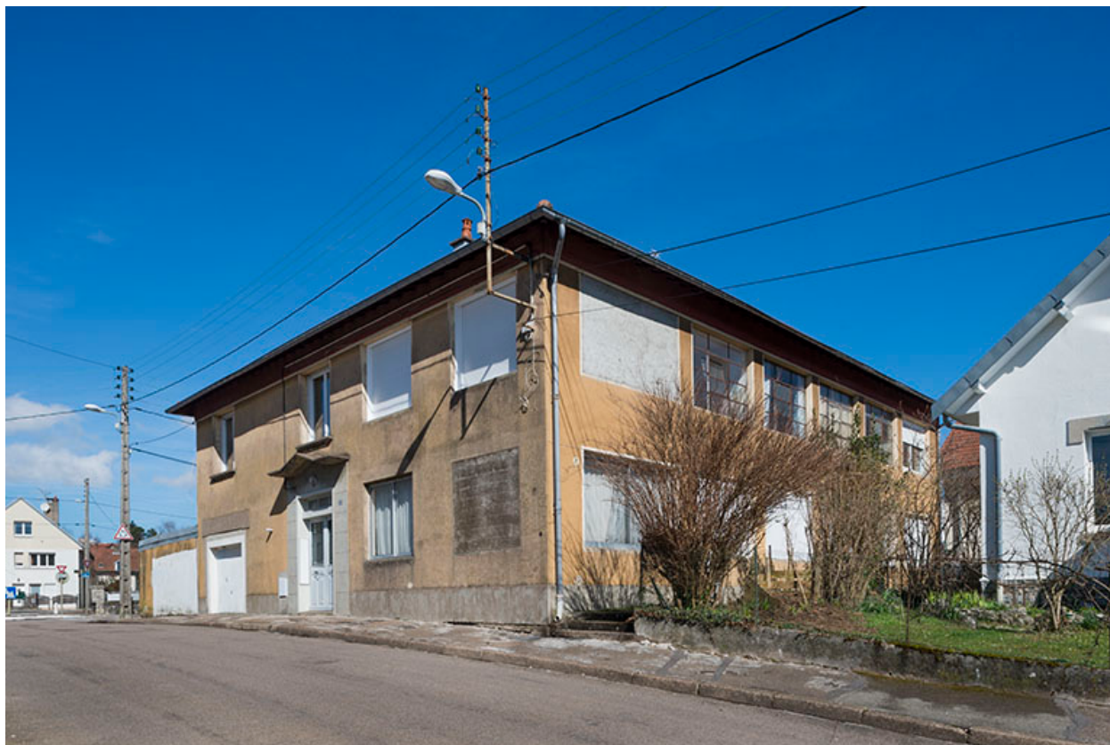
Vue d'ensemble depuis le sud.
