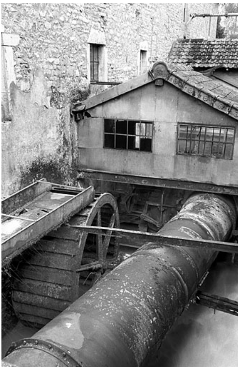
Roue hydraulique, conduite forcée et bâtiment d'eau.
