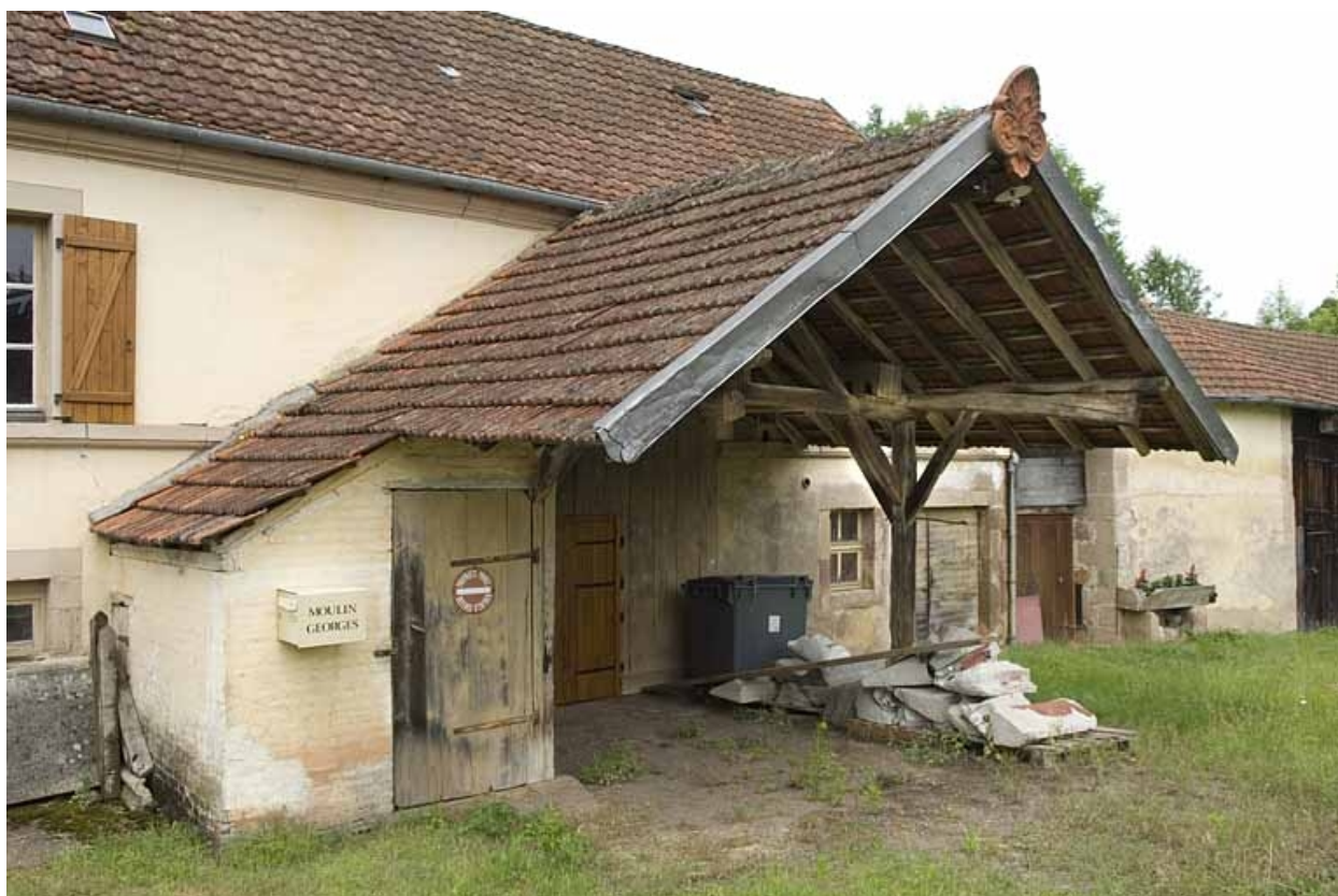
Auvent sur la façade antérieure.
