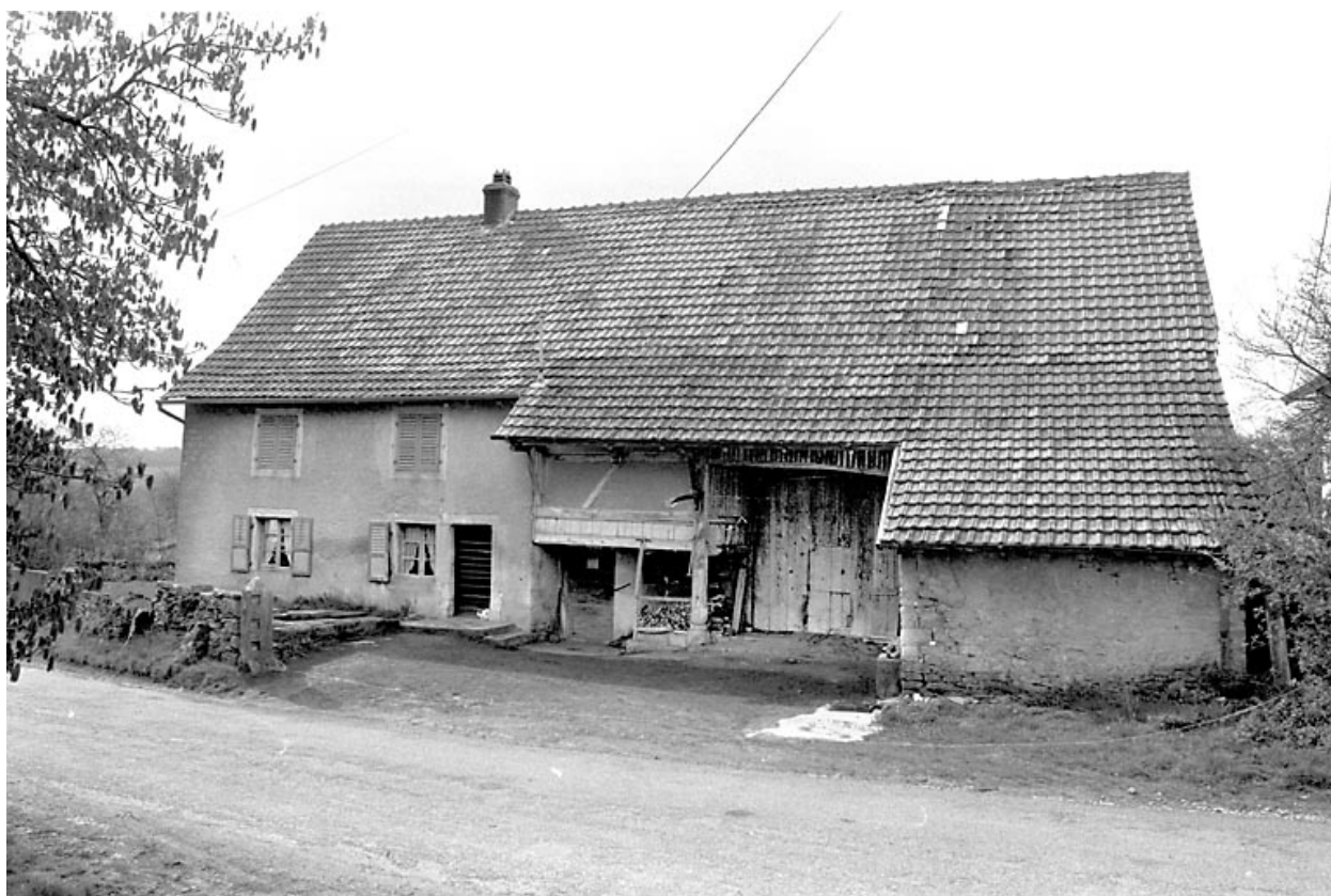
8e ferme : vue d'ensemble.
