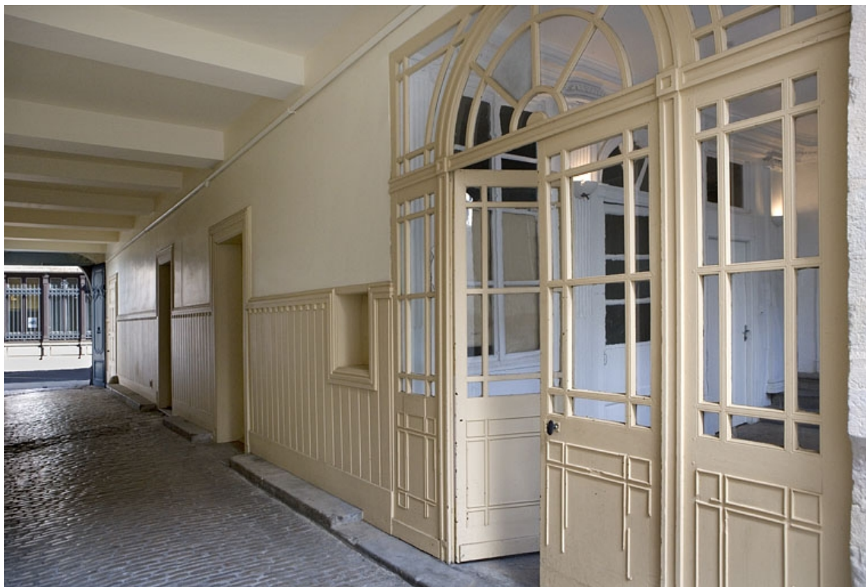
Entrée du vestibule depuis le passage cocher.
