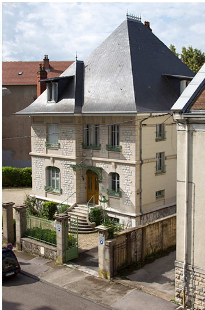
Vue plongeante sur la façade antérieure.
