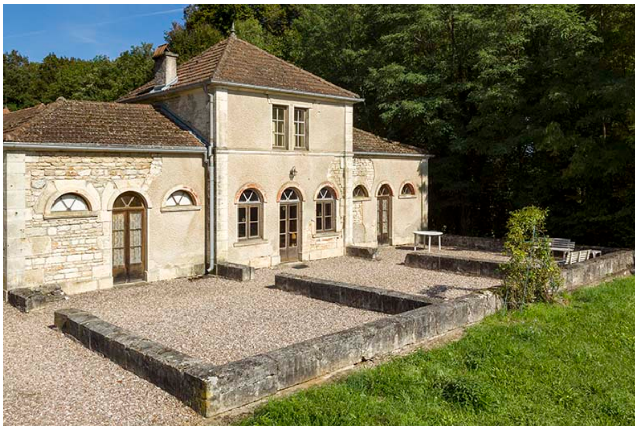
La façade antérieure, exposée au sud-est.
