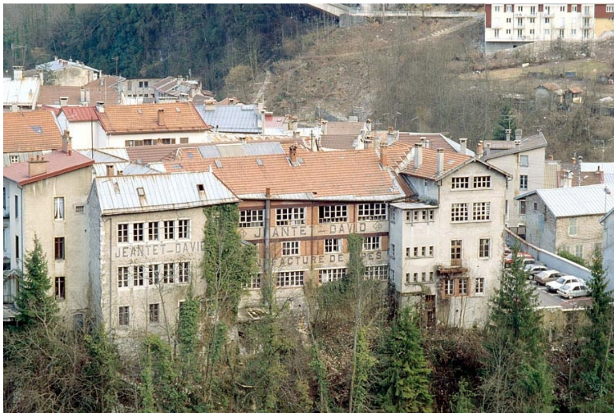
Vue d'ensemble rapprochée depuis l'ouest.
