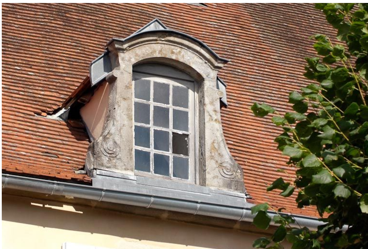
Lucarne de la façade antérieure.
