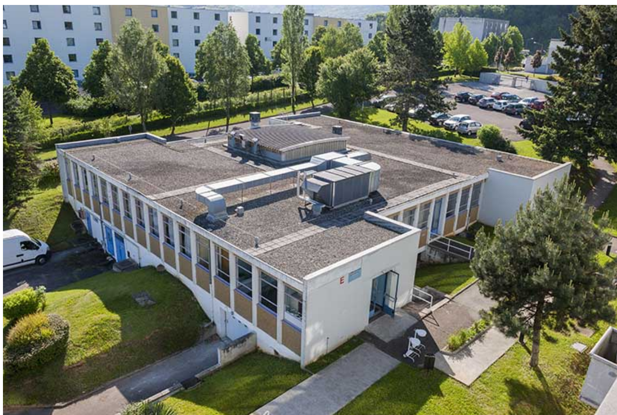
Angle nord-ouest du bâtiment de restauration.
