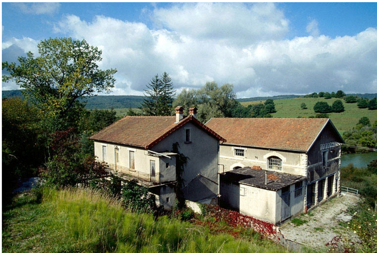
Centrale hydroélectrique de Chalain, Marigny.
