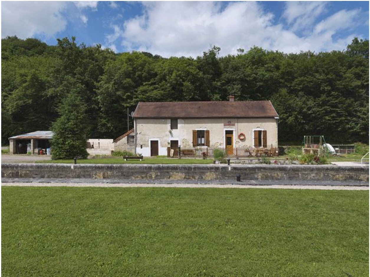
Maison éclusière vue de face.
