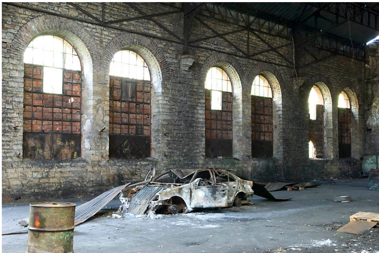
Mur nord du bâtiment des vestiaires.
