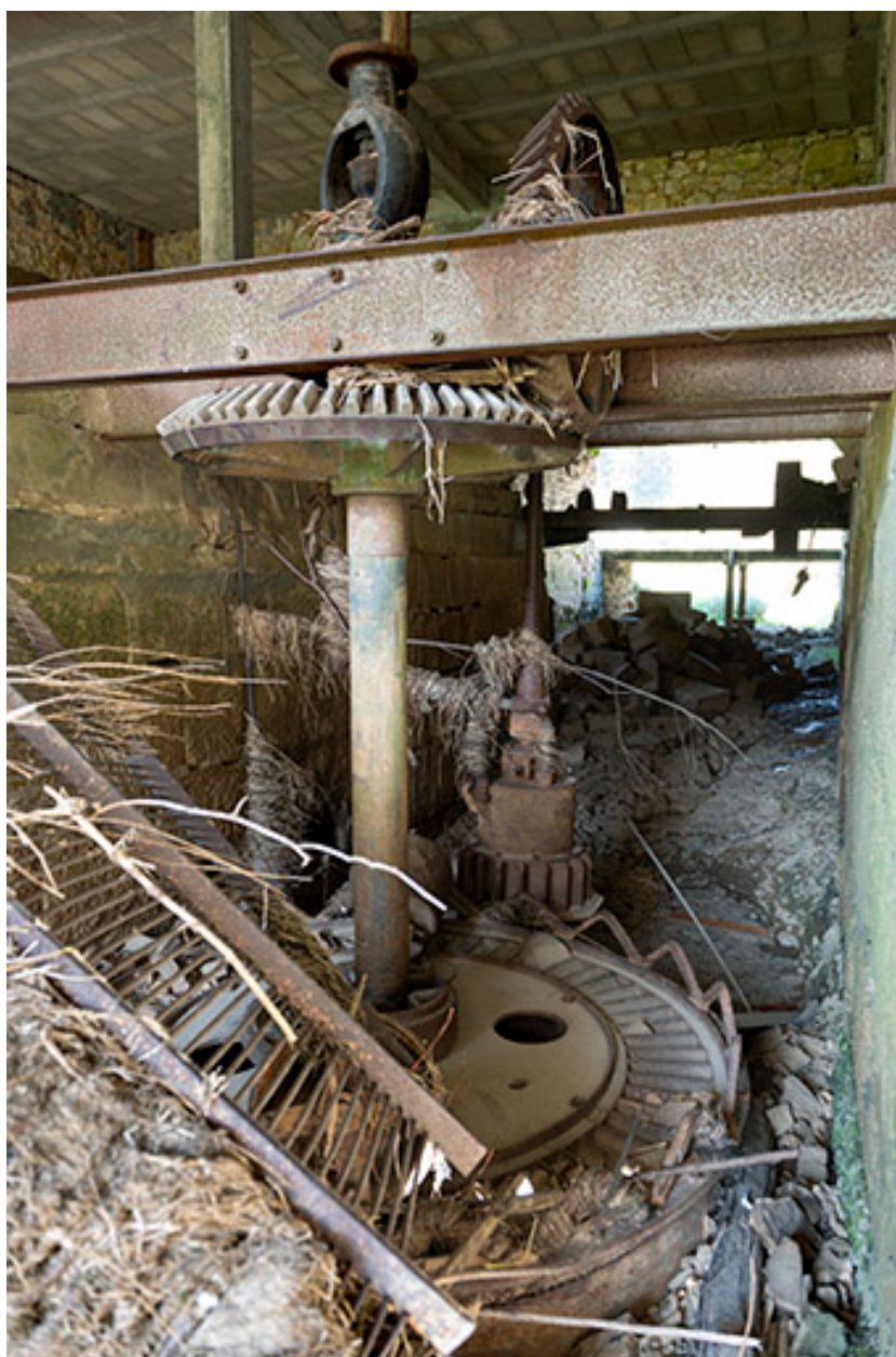
Moulin : turbine Pouguet.
