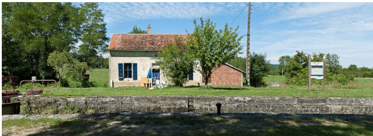
Vue de face de la maison éclusière.
