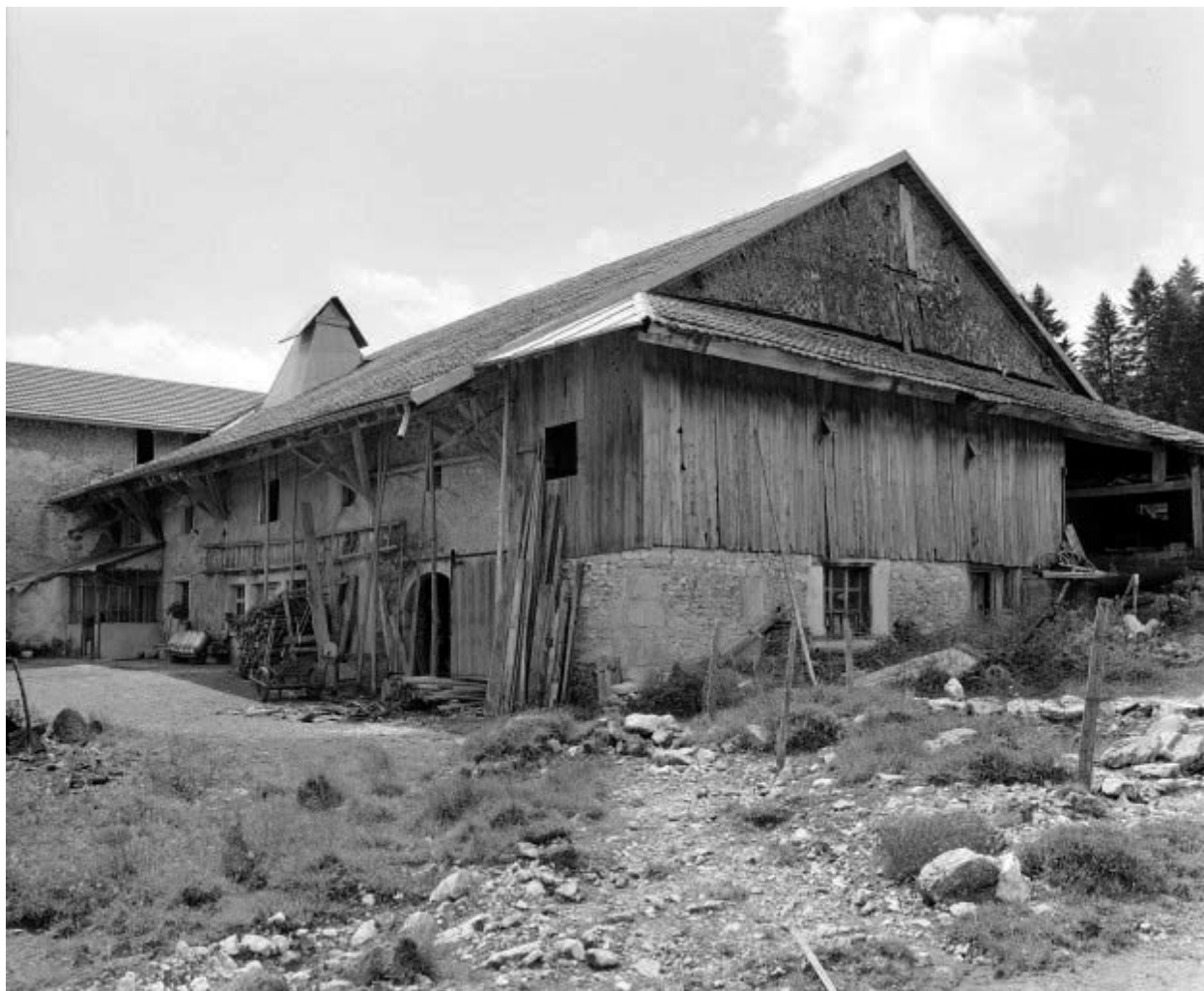
Facades postérieure et latérale droite.
