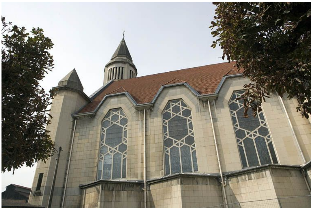
Vue extérieure de la nef.
