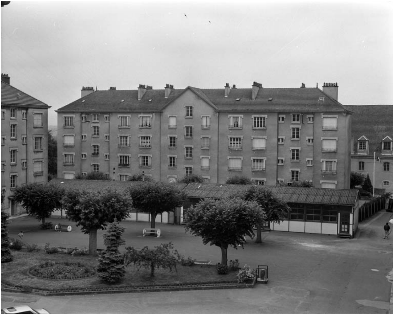
Place centrale de l'ancienne caserne : logement droit.
