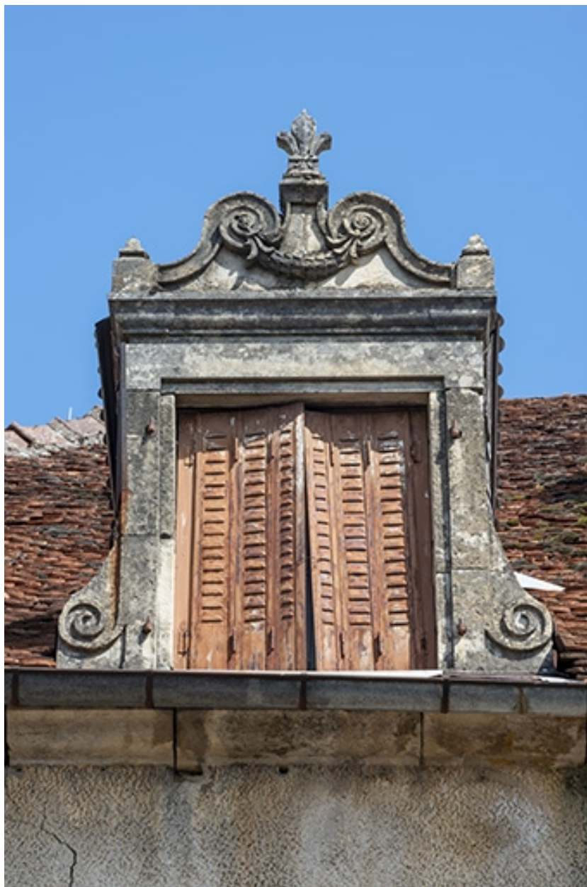
Détail de la lucarne gauche.
