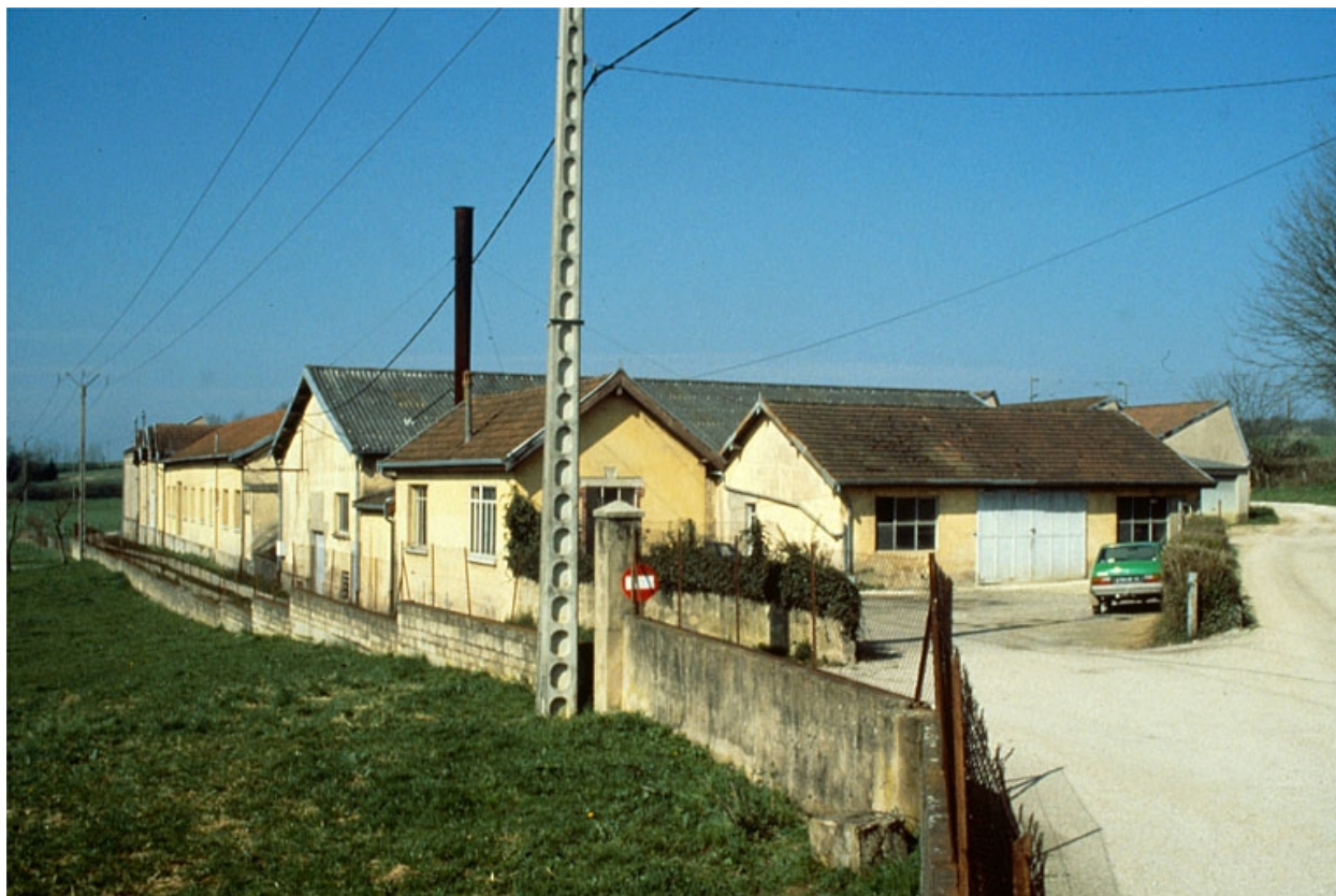
Entrée de l'usine.
