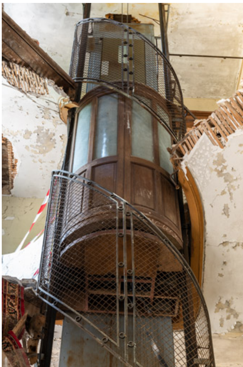
Ascenseur de l'escalier ouest, cabine.
