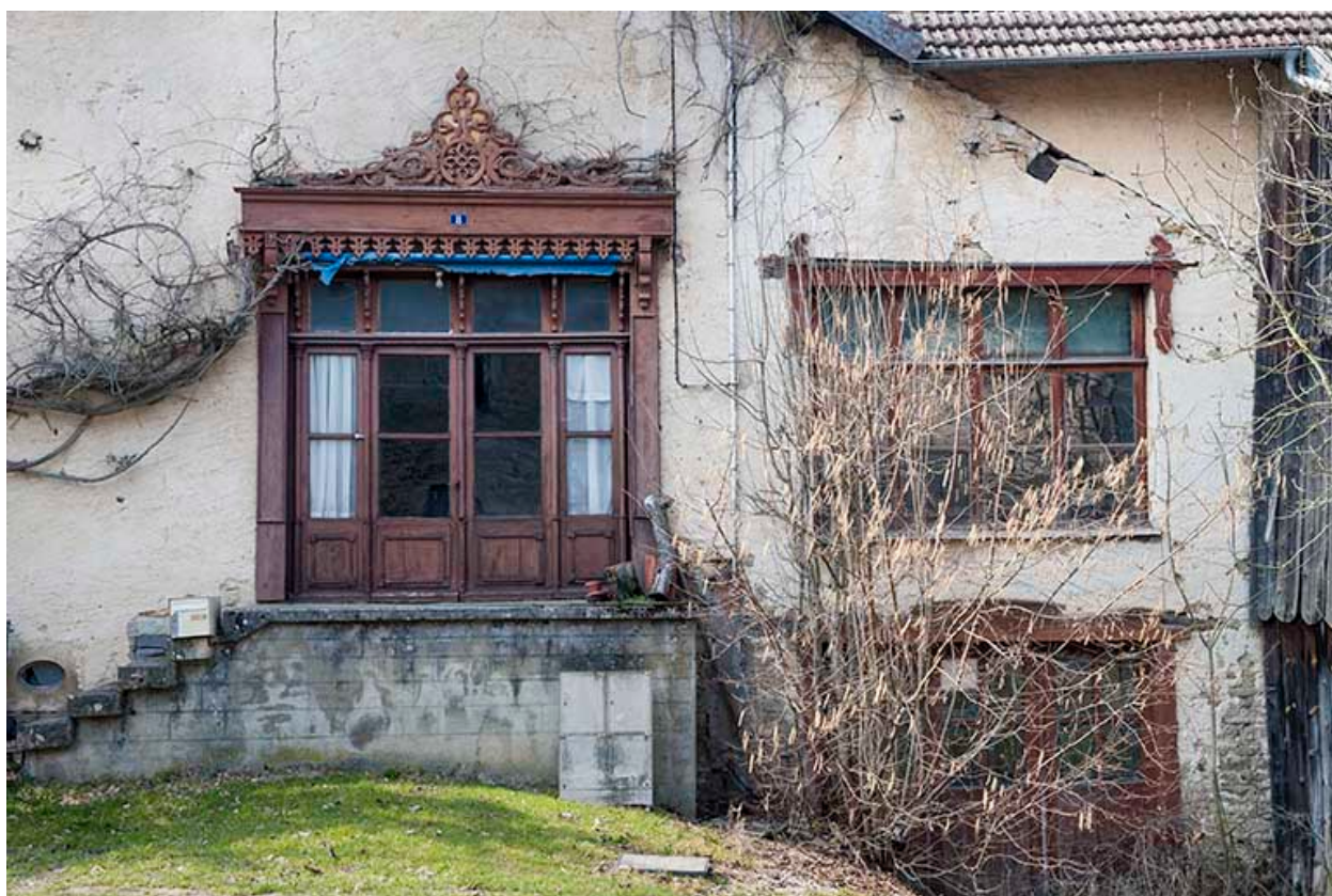
Façade sud. Entrées des ateliers.
