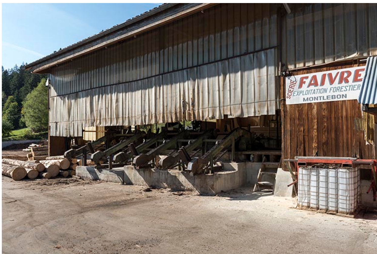
Atelier de fabrication (2000) : façade sud.
