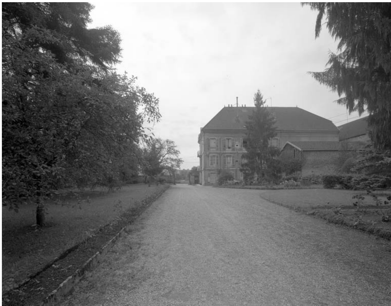
Façade postérieure depuis le fond du parc.
