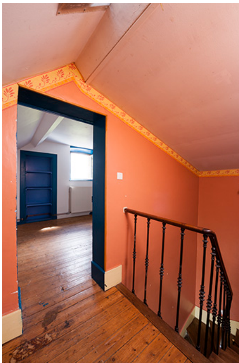
Palier de l'étage, maison du barragiste.
