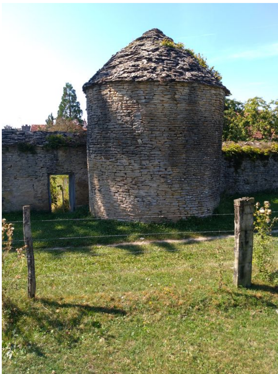
Vue de la tour depuis le nord-est, avant restauration.
